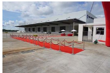
物流倉庫の正面
