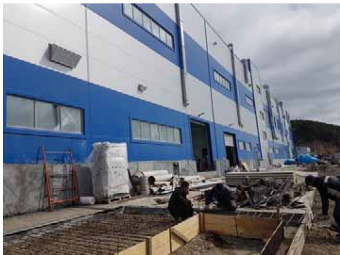
建設中の水産加工場
