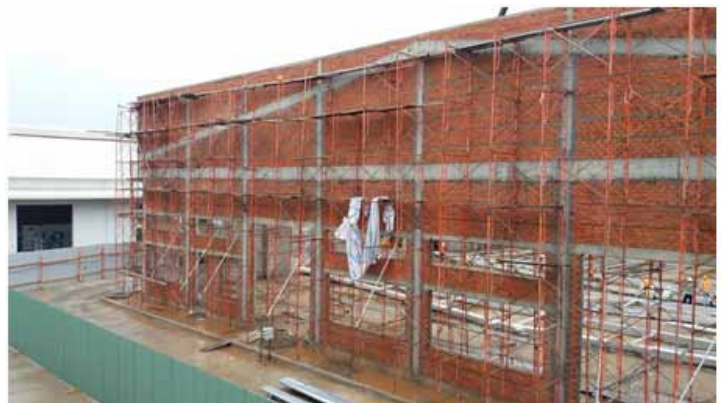
建設中の2棟目のレンタル工場(ジェトロ撮影)
