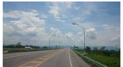
タイ・ラオス国境にある第4タイ・ラオス友好橋
