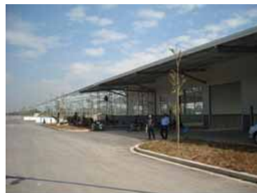
建設の進む絆レンタル工場
